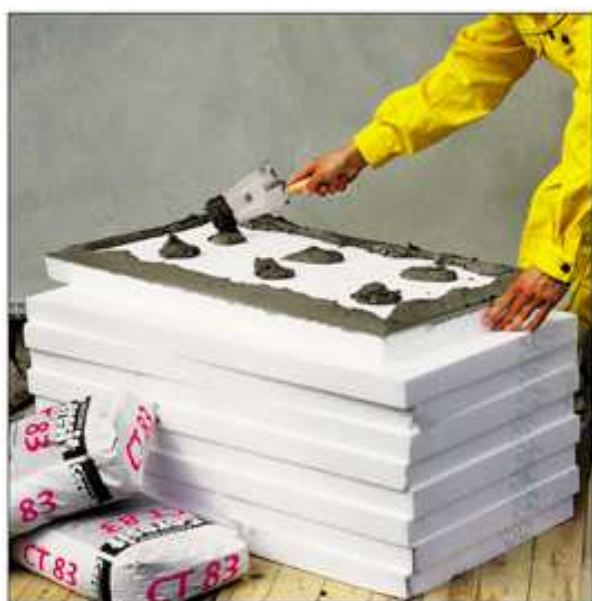
Лепилото се нанася върху гърба на всяка плоча на симетрични купчинки и по периферията
